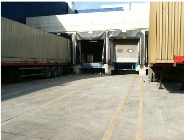
Strisce di demarcazione per favorire la manovra di accostamento
