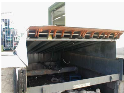
Rampa di carico motorizzata
