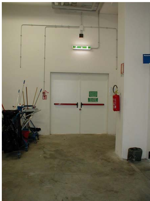
Vie d'emergenza sgombre da materiali
