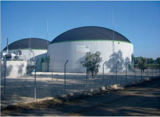
Figura 35: Cupola gasometrica (Fonte: Inail)
