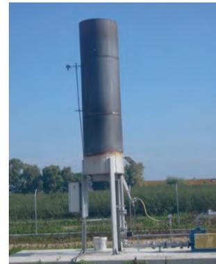
Figura 38: Torcia di emergenza (Fonte: Inail)
