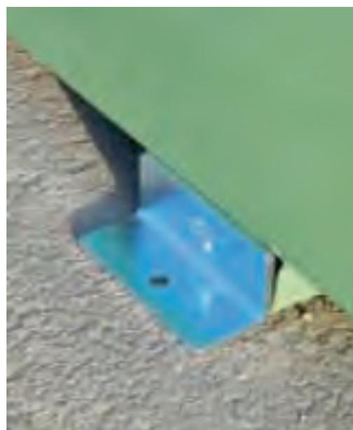
Figura 15: Zanca di ancoraggio
