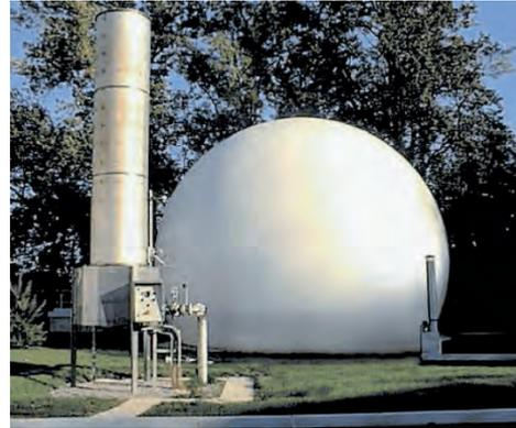
Figura 36: Pallone gasometrico (Fonte: Inail)
